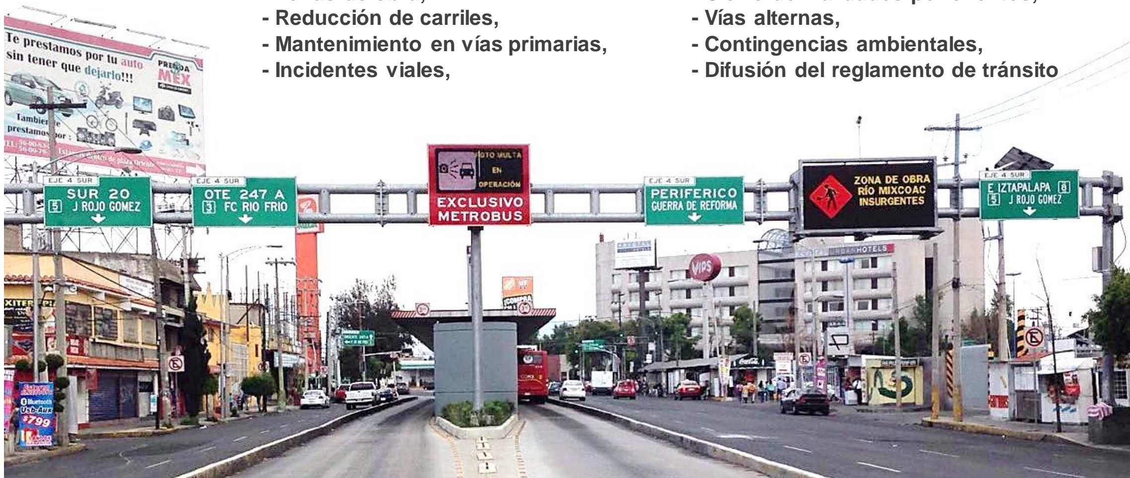
Pantalla de LED y Señalamiento Vertical Alto con doble módulo
